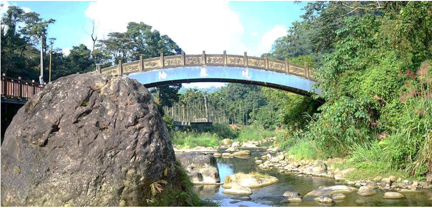
圖/抽藤坑 資料來源：抽藤坑休閒農業區臉書
